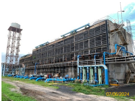
ภาพที่ 2.2-11 ระบบปรับปรุงคุณภาพน้ำ จากหอหล่อเย็น
