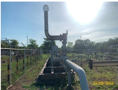
ภาพที่ 2.2-40 การติดตั้ง Pressure Relief Valve
