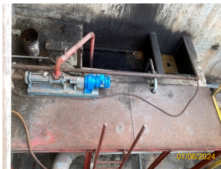
ภาพที่ 2.2-10 ระบบดักตะกอนและแยกคราบน้ำมัน
