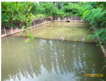
ภาพที่ 2.2-14 บ่อตกตะกอนสำหรับรองรับน้ำฝน บริเวณพื้นที่ลานกองเศษเหล็ก
